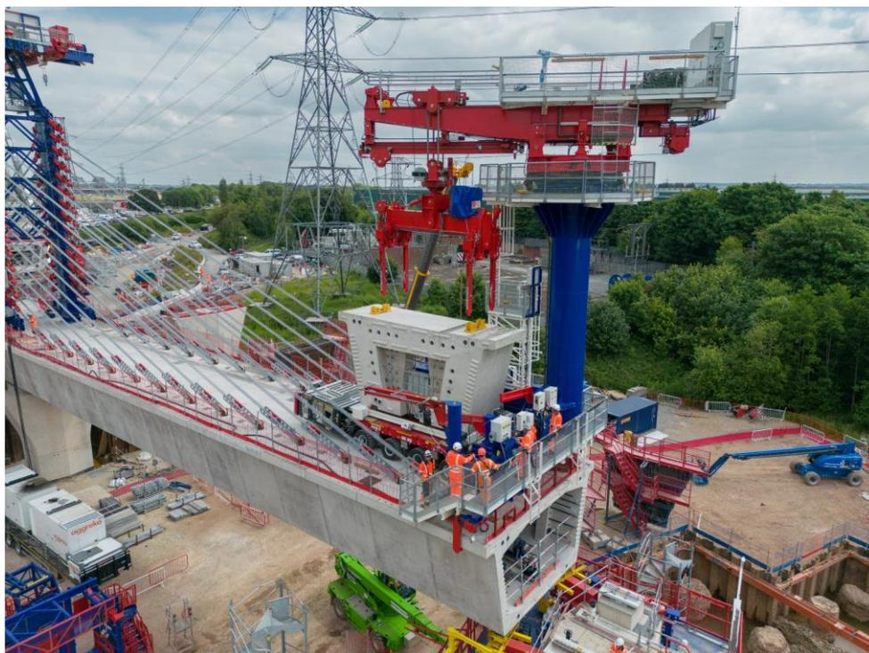
Mise en place de voussoirs sur le chantier High Speed 2 (HS2) au Royaume-Uni
